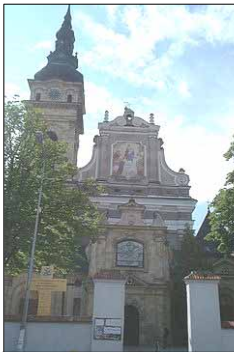
Klasztor o. dominikanów. Elewacja frontowa - wschodnia
