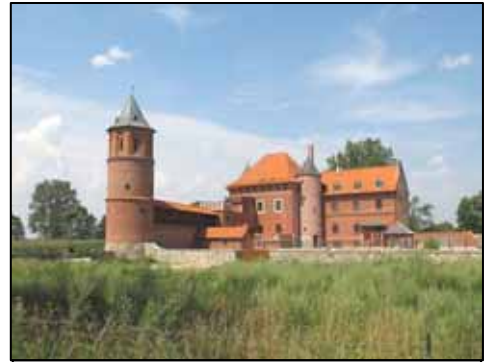
Zrekonstruowany fragment zamku w Tykocinie - widok od strony wschodniej
